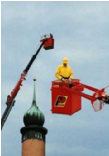
Arbeitsplattformen, die mit Ladekränen zusammengebaut sind
